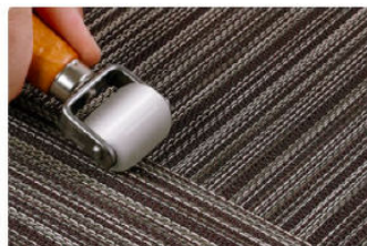
1-Alisar las juntas con el rodillo de vapor pequeño.
