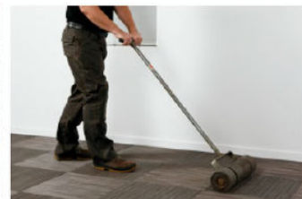
2-Alise toda el área del suelo con el rodillo grande y pesado.
